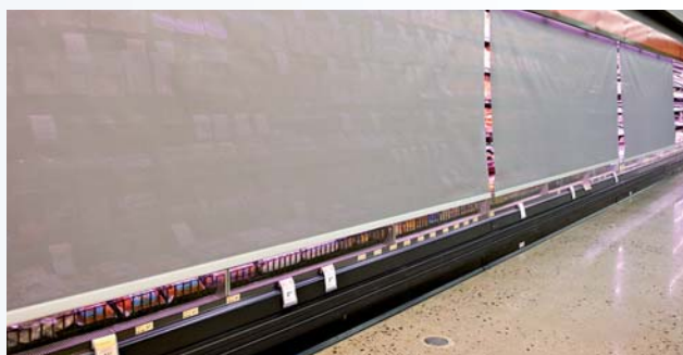
Il reparto frigorifero durante il giorno e, qui sopra, ricoperto dalle tende elettriche durante la notte
